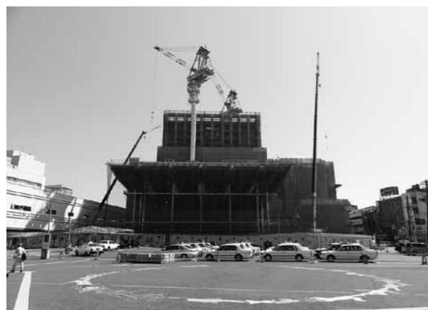
工事中の福井駅西口再開発ビル
