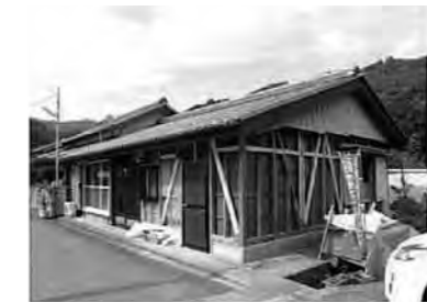
住宅耐震改修のようす
