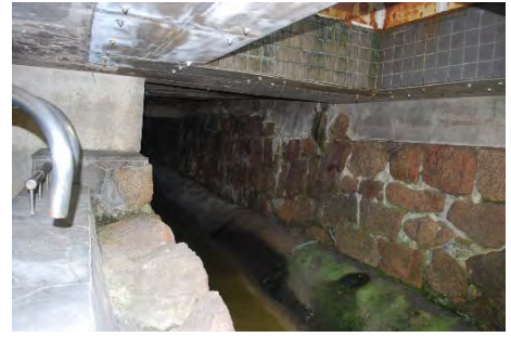
背割（太閤）下水／中央区農人橋に現存。付近の下水を地表の勾配に合わせて東から西へ流し、東横堀川に排水する。内のりの幅・高さ共に約2m、高さ7段・横2列の石積み。
